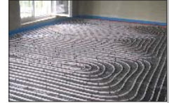
Fußbodenheizung
