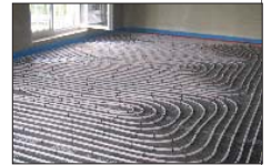
Fußbodenheizung
